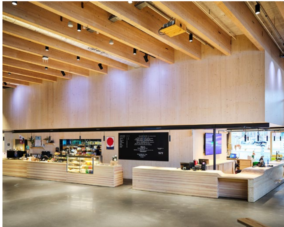
Även en del inredning är byggd i KL-trä och Frontwood, till exempel bänkar, skjutdörrar och ventilationsgaller.
