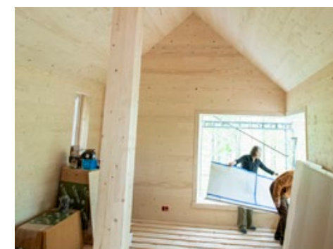
Invändigt ska väggarna av KL-trä endast behandlas med vitpigmenterad oljeväx.
